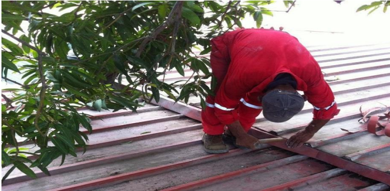
Reparaciones de Techos
