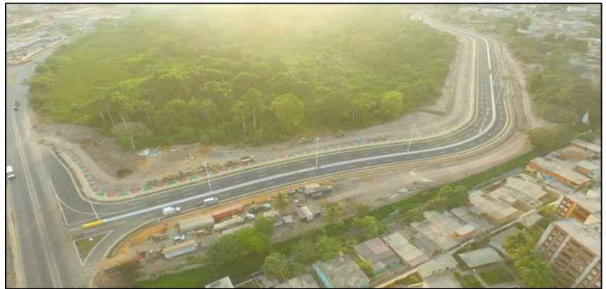
Carretera La Acequia (2016.05. Inicio)
