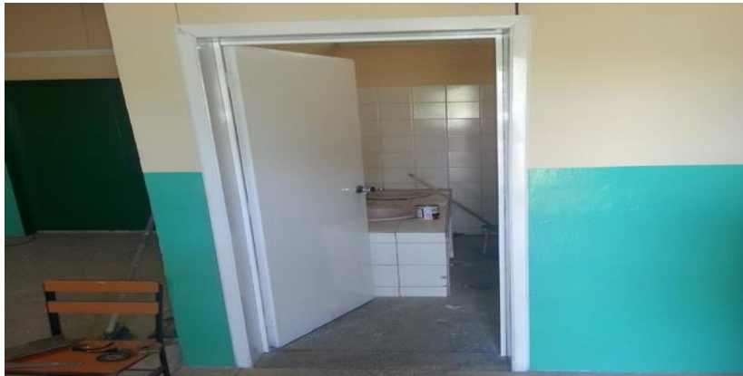
Reparaciones de Puertas
