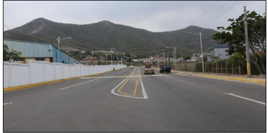
Carretera JAA (2015.10. Terminada)
