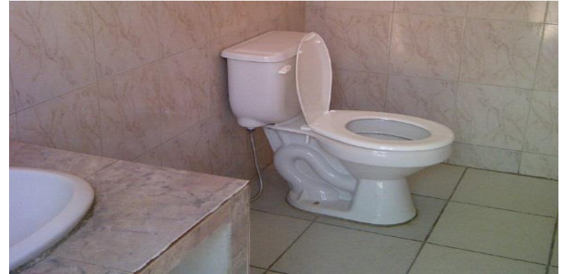
Remodelación de Sanitarios
