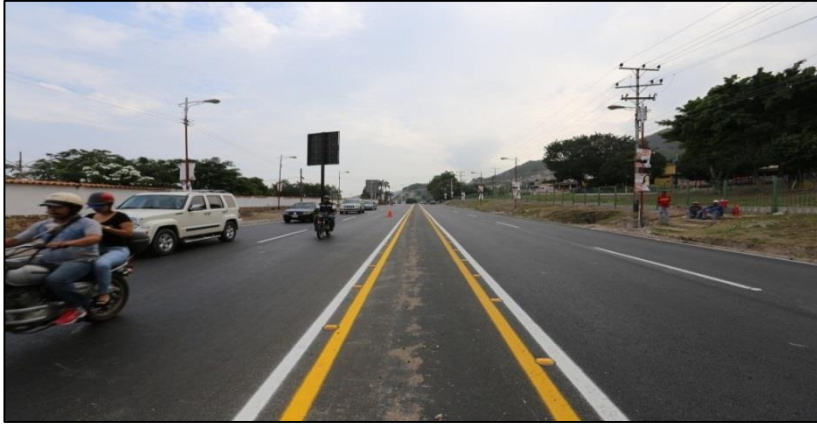
Carretera Igor Rodríguez (2015.10. Terminada)
