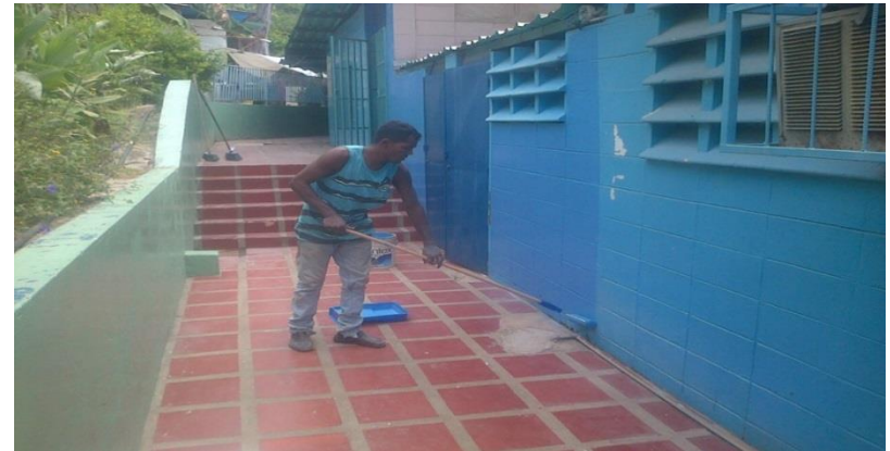
Pintura de Muros
